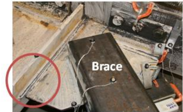
(d) Weld Failure in Opposing Gusset
